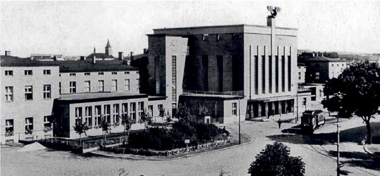
Hlavní nádraží po předválečné přestavbě. Foto: archiv Milana Hořínka
